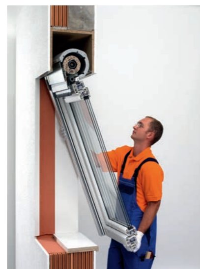
Fenster mit TERMO einsetzen
