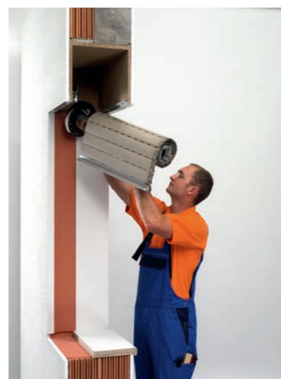
Alten Rollläden aus Kasten entfernen
